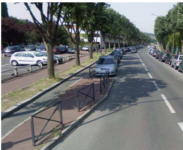
Bd à 50 avec piste entre trottoir et stationnement (Fontenay aux Roses / Sceaux RD75)
