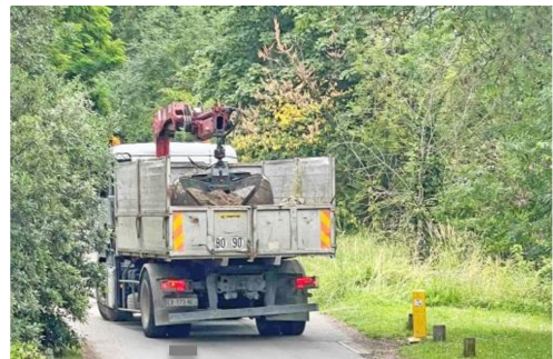
Chargement de terres de remblais arrivant sur le site le 21 juin 2024, en dépit de l'arrêté préfectoral du 10 juin
