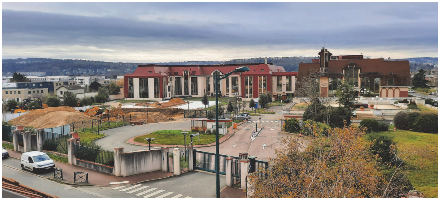
Ancien établissement Servier à Croissy-sur-Seine au moment des travaux de dépollution du sol dans le périmètre de l'ancienne cuve Sovcor (déc. 2023) © AdCR
