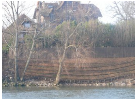
2006: un linéaire de berges (secteur 5) est réhabilité en génie végétal.
